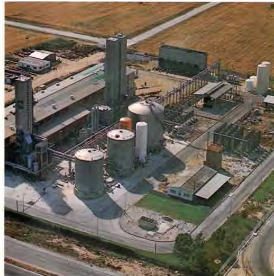
Die beiden Luftzerlegungsanlagen der Carbueros Messer Griesheim Gases Industriales S.A. in Tarragona haben zusammen eine Stunden- leistung von 15 000 m 3 Sauerstoff, 8 000 m 3 Stickstoff, 400 m 3 Argon.
