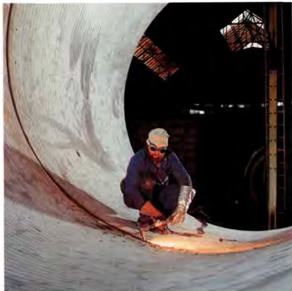
Vorbereiten der Schweißnaht an einem Reaktor für die Chemische Industrie aus plattiertem Stahl in der Behälterfertigung bei einem Kunden in Brescia, Italien, mit dem Fugenhobel FH.
