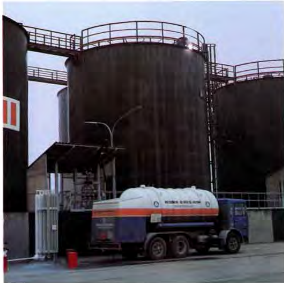
Zuverlässige Reparatur eines Großbehälters für Mineralöl. Inertisieren mit Stickstoff zum Vermeiden einer Explosion ermöglicht die sichere Schweißnaht. Eine Aufgabe, die Messer Griesheim Austria bei Shell in Linz löste.
