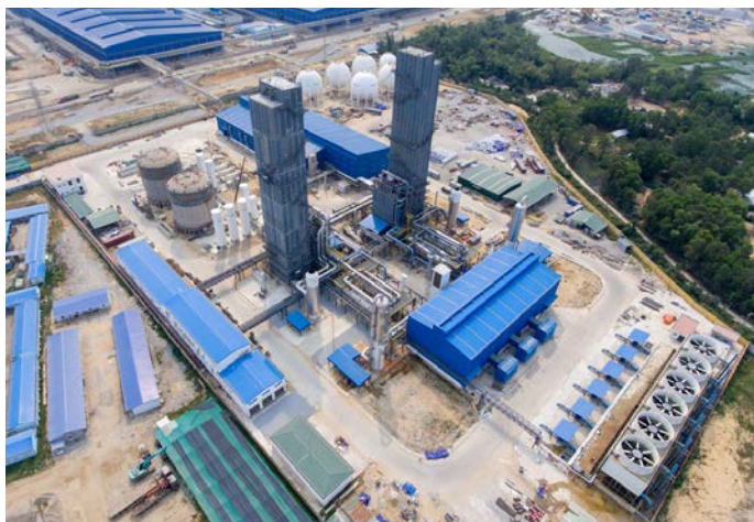
Luftzerlegungsanlagen in Dung Quat, Vietnam, im Bau
