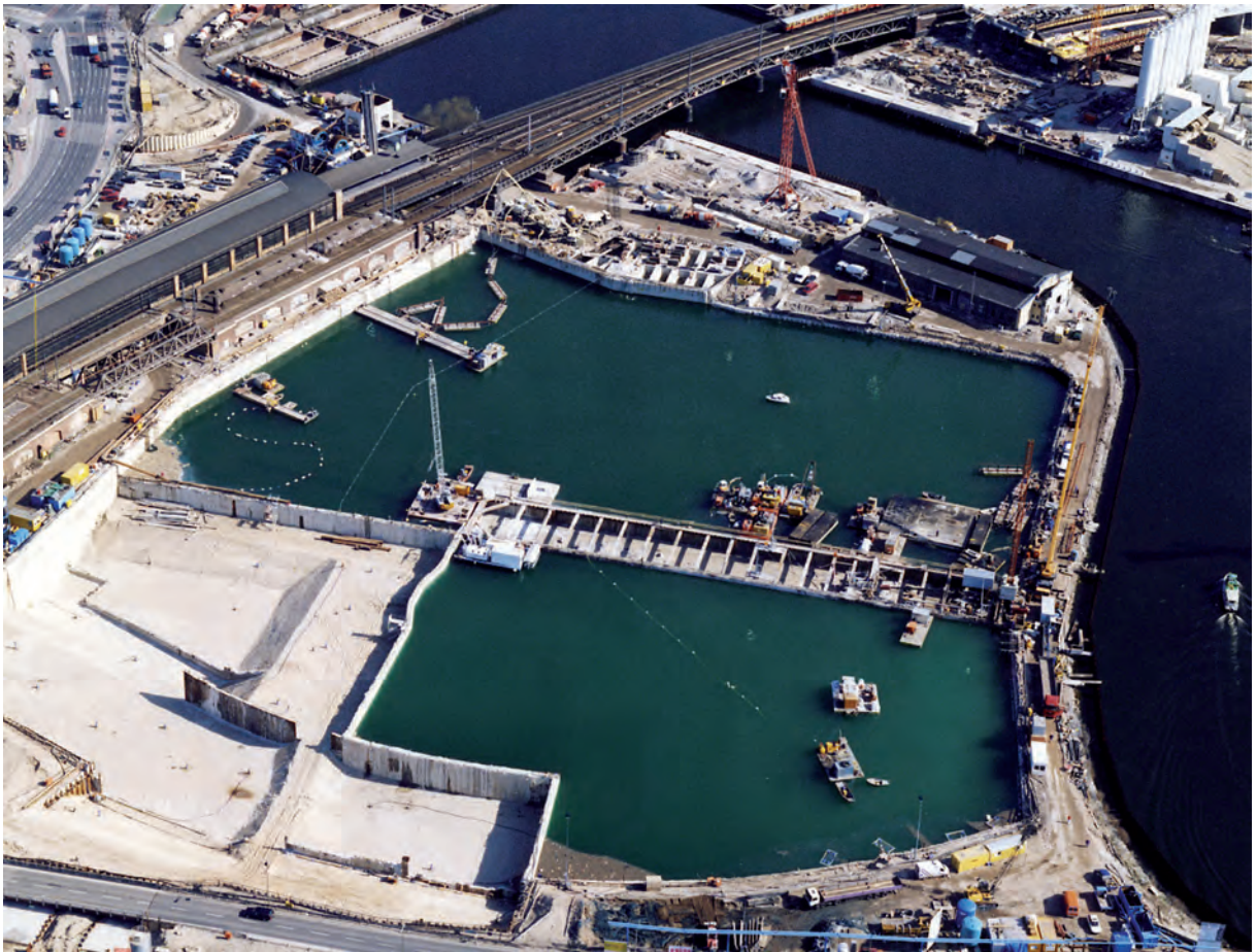
Slika 4: Neutralizacija gradilišta korištenjem CO 2 na berlinskoj Glavnoj stanici, ranije stanici Lehrter.
