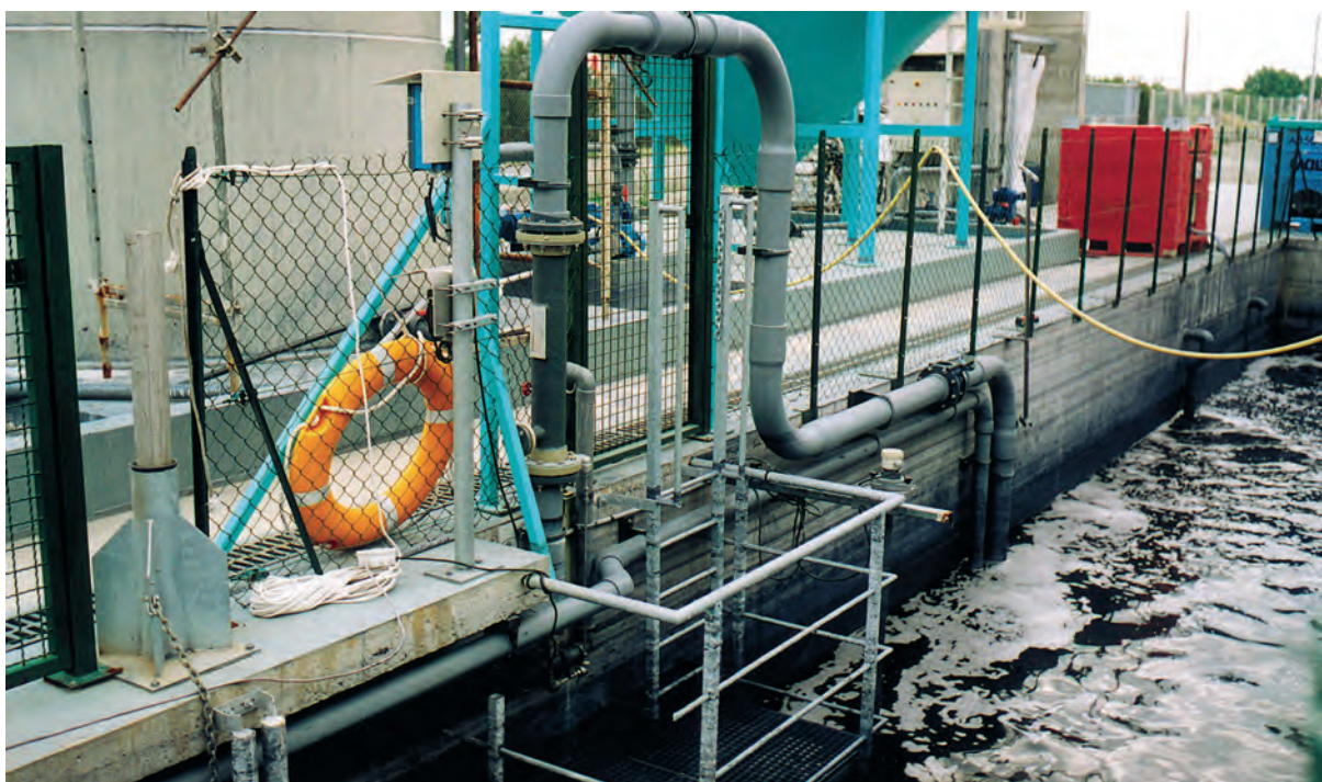
Slika 7: Neutralizacija alkalne otpadne vode iz tekstilne industrije korištenjem CO 2
