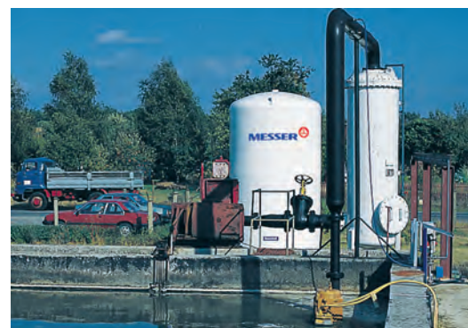
Slika 1: Tehnika injektiranja čistog kisika razvijena od strane Messera: crijevo za dovod plina (lijevo), injektor (sredina), oksidator (desno)
